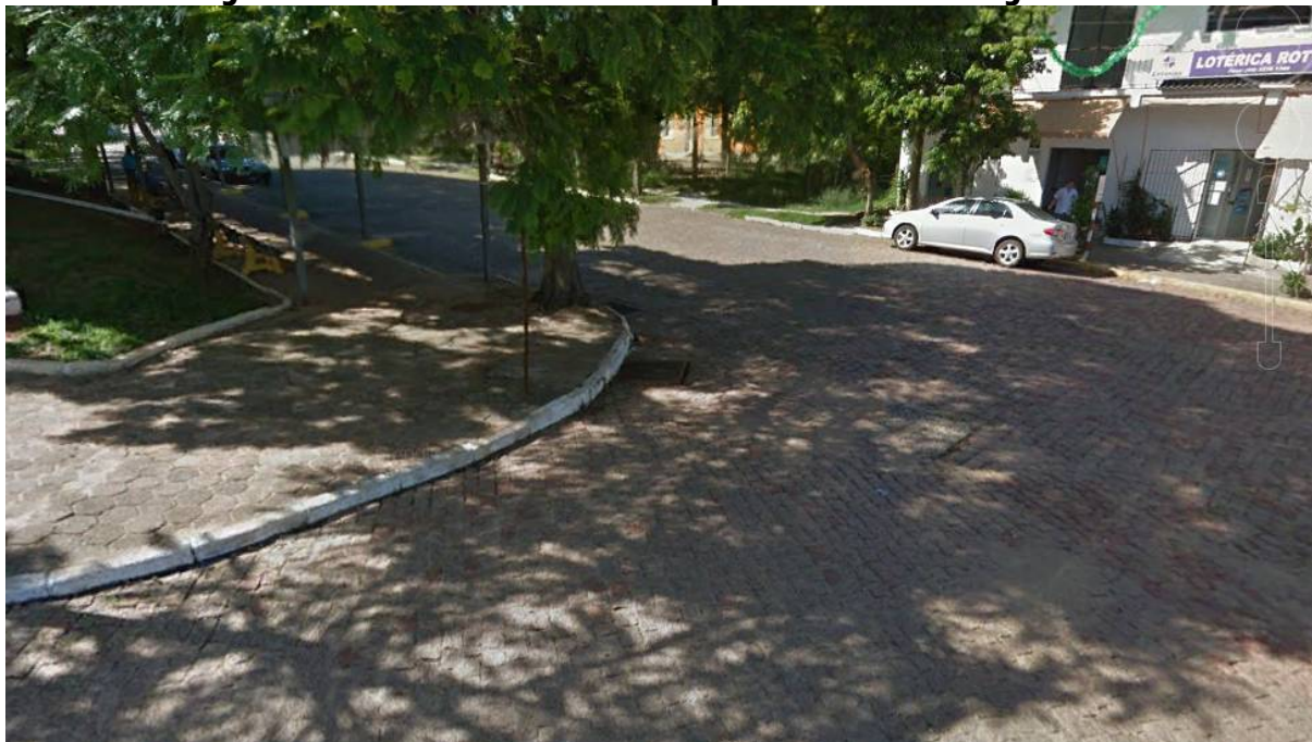
Imagem 05: Local relatado com problemas de alagamento.
